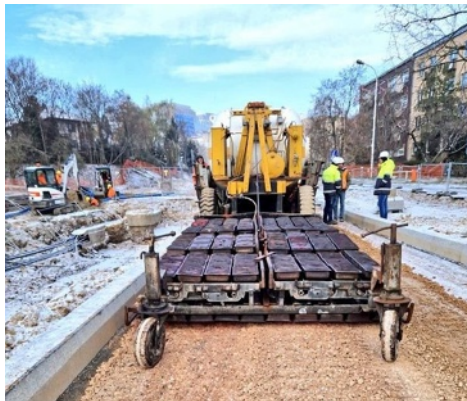
Specjalna nagrzewnica rozmraża podłoże na ul. Spacerowej przez asfaltowaniem (fot. Budimex).
